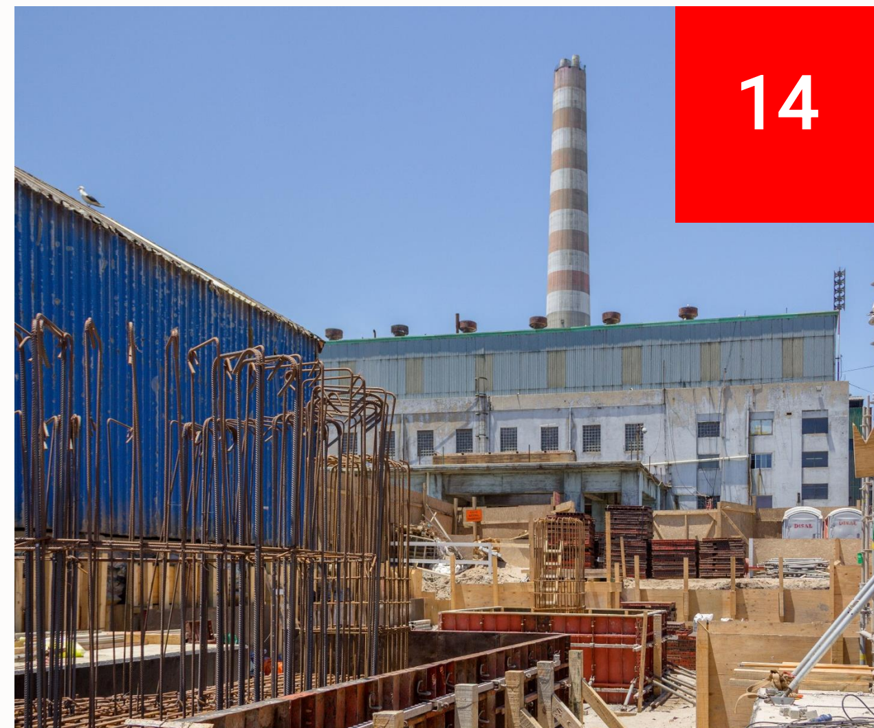
EPC CODELCO VENTANAS .....
